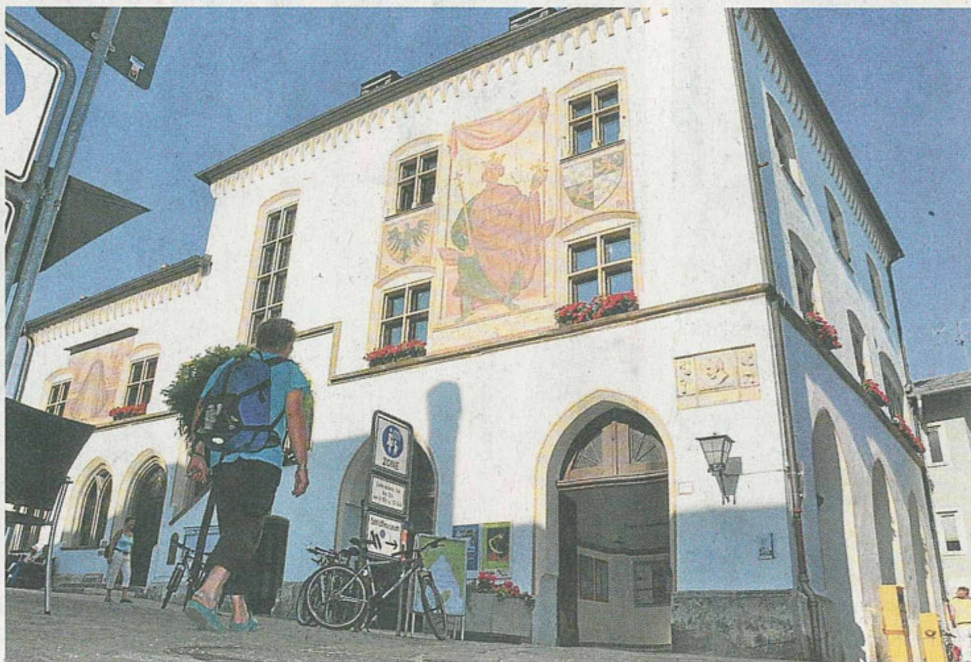
Sanierungsfall: Das Murnauer Rathaus wird auf einen modernen Stand gebracht. FOTO:LORY
